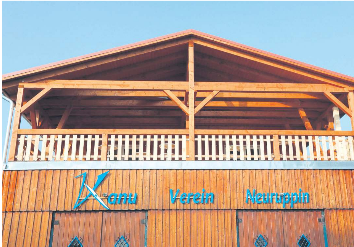
Das Vereinsgebäude des SV Kanu Neuruppin hat eine zweite Etage bekommen. Dort sind der neue Clubraum und vor allem die schöne große Terrasse entstanden.
